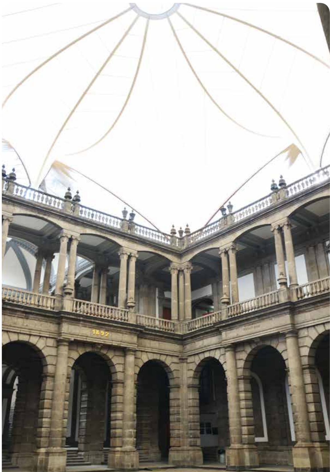
Patio Principal, Planta Baja; Palacio de Minería
